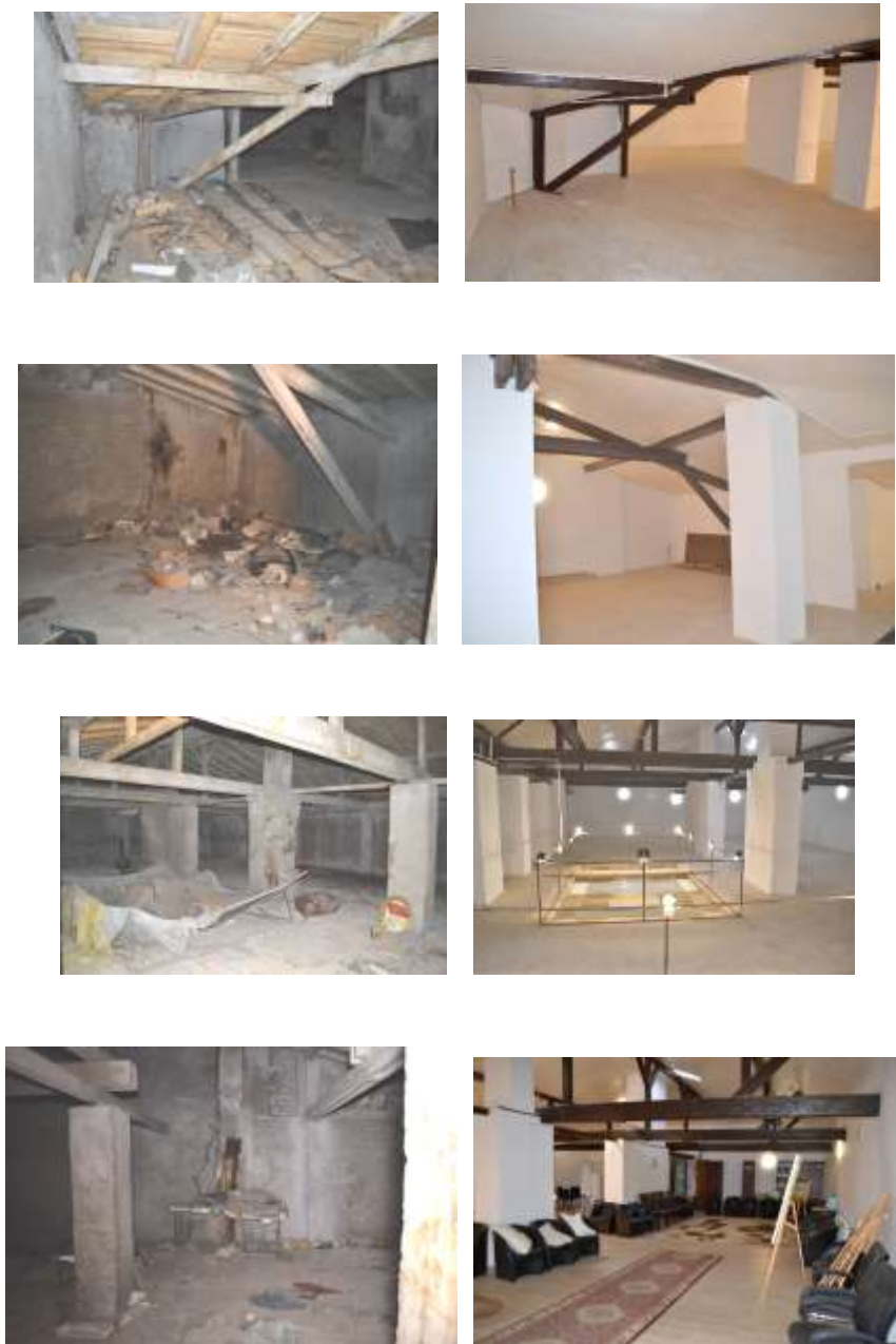
Fig. 2.35. Noul sediu AOSR din str. Ilfov nr. 3, înainte și după lucrări de renovare
