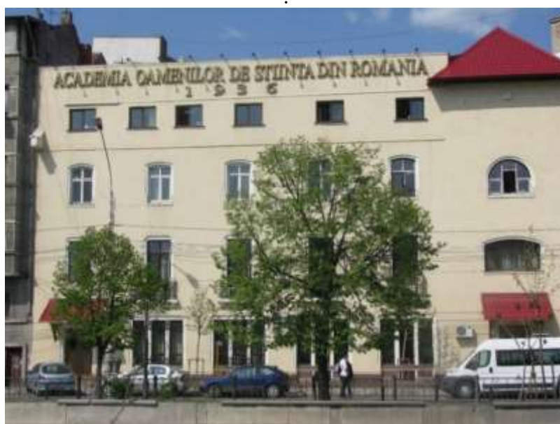
Fig. 1.14 Fațada, după reabilitare, în 2009
