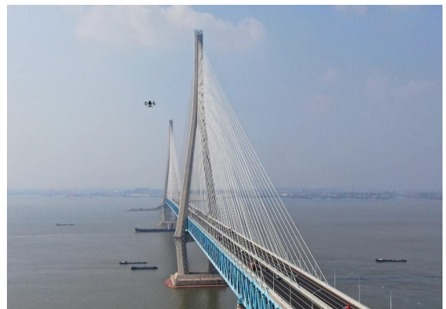
Fig. 4. Inspection du pont suspendu par drone [7]
