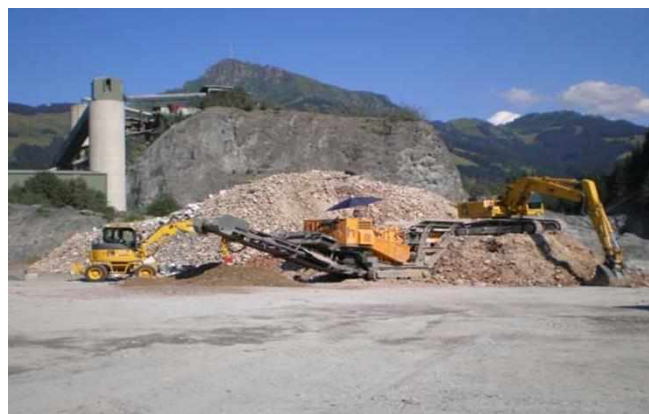
Fig. 5 – Installation mobile de concassage du béton issu des démolitions
