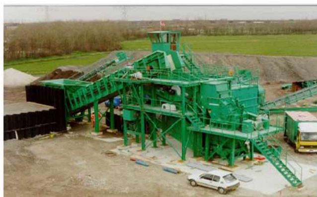
Fig. 4 – Installation fixe de concassage du béton issu de démolitions
