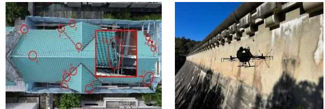
a) Inspection toiture [18] Zones de risque [19]
